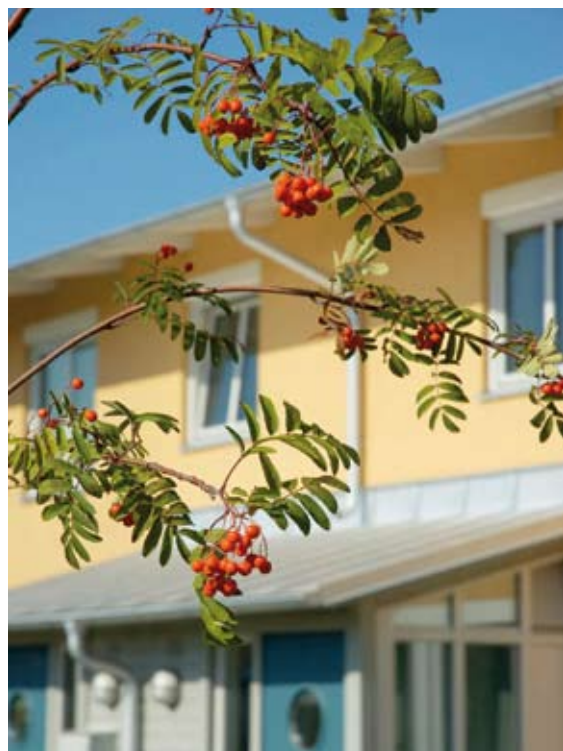
Passivhusen i skånska Glumslöv är ett utmärkt exempel på energiklokt byggande i kombination med god arkitektur.
